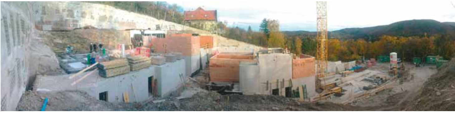
Panoramaaufnahme während der Bauphase. Foto: x42
