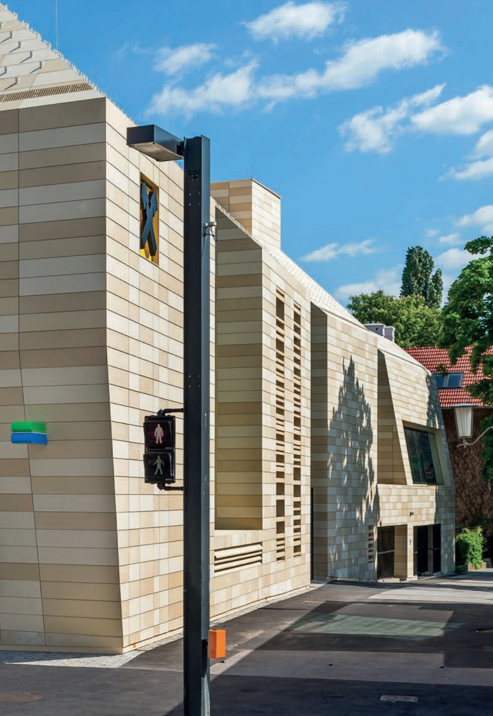
Der strukturierte Baukörper gibt der schmalen Gasse Raum
