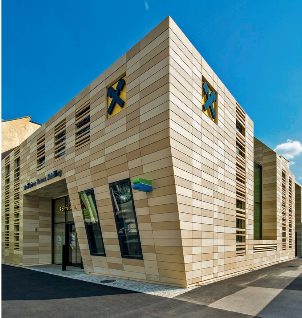
Monocover-Fassade aus keramischen Platten
